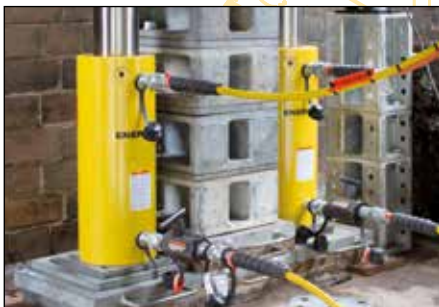
Подъем и установка мостов
