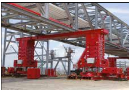
Циклическая навдвижка мостов
