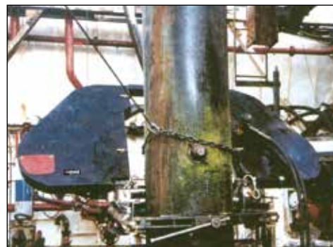
▼ Работы по демонтажу с использованием ленточной пилы.
