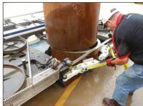
▲ Резание трубы портативной ленточной пилой Mirage BS.
